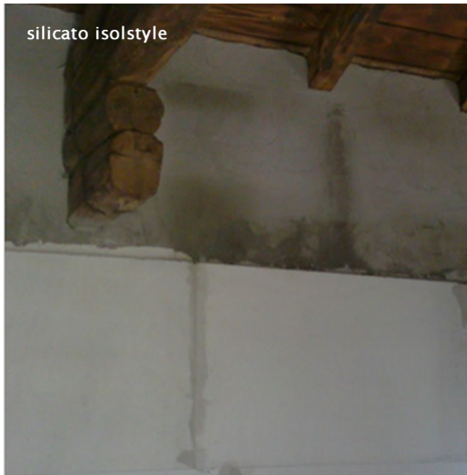
Applicazione in aderenza su parete in pietra intonacata
